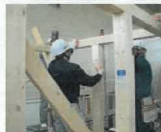
▲ 木造軸組加工法による建物組立の実習
