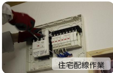
ケーブル配線作業
