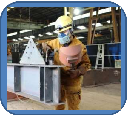
溶接作業段取り
