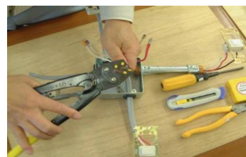
電気配線工事
