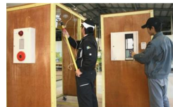
消防設備（検知確認）
