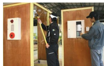
消防設備（検知確認）
