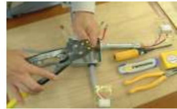
電気配線工事
