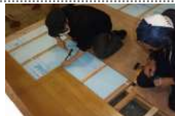
フローリング施工
