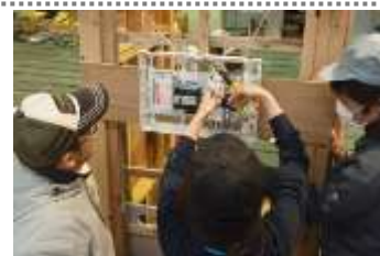
電気配線施工
