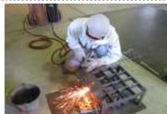
ガス切断作業
