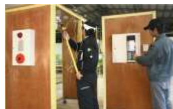
消防設備（検知確認）
