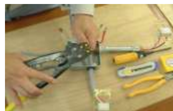
電気配線工事
