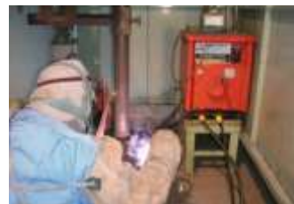
被覆アーク溶接
