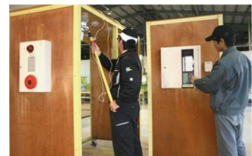
消防設備（検知確認）
