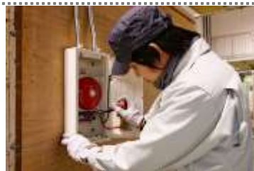
消防設備の施工
