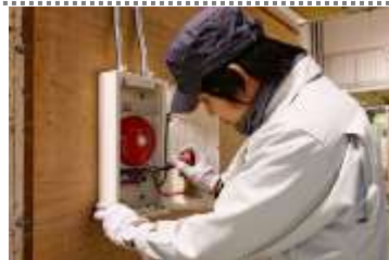
消防設備の施工
