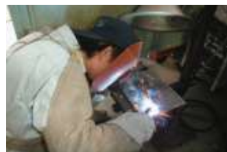
半自動炭酸ガスアーク溶接
