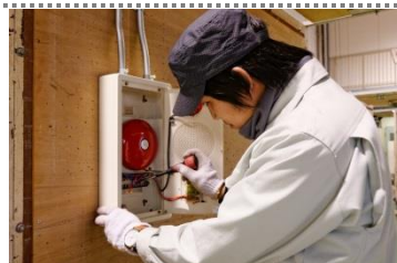
消防設備の施工
