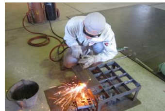
ガス切断作業
