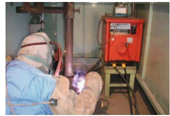
被覆アーク溶接
