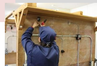
屋内配線工事実習
