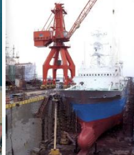
北転船ドック 修繕工事
