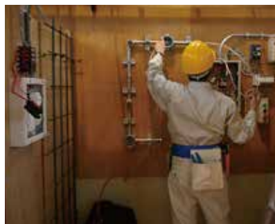
金属管配線実習
