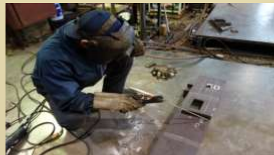
溶接作業風景
