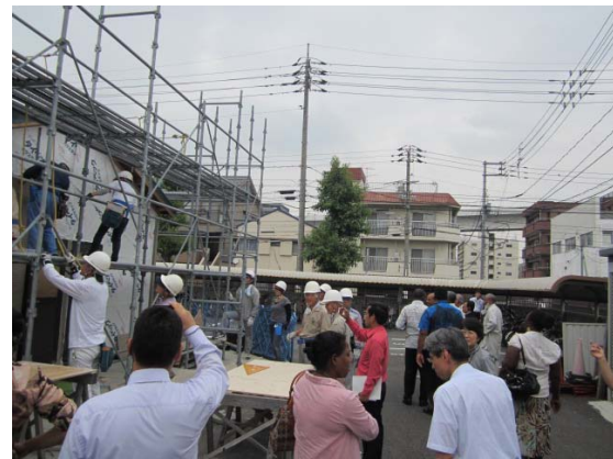
建築実習場の見学
